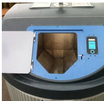
L'élimination des déchets à Nods s'effectue à l'aide de conteneurs semi-enterrés avec une balance intégrée pour la taxe au poids. Tout type de sac peut y être déposé jusqu'à 60 L. Ces conteneurs s'ouvriront à l'aide d'une carte.
